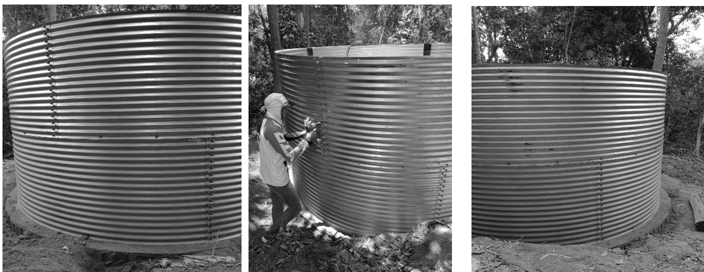
Construcción del tanque
