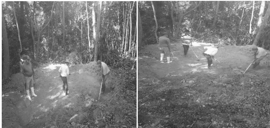
Adecuación del terreno para instalación del tanque
