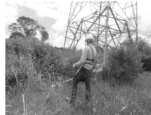
Mantenimiento sitio de torre
